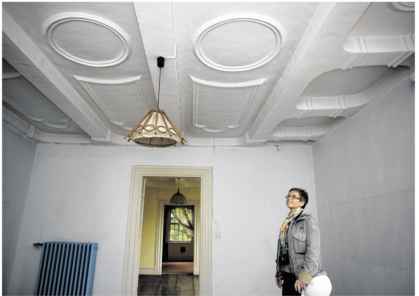
Denkmalhüterin Ina Hanemann blickt auf die Kölner Decke im Haus Harkorten: „Ich will Gebäude über die Ewigkeit bringen.“
